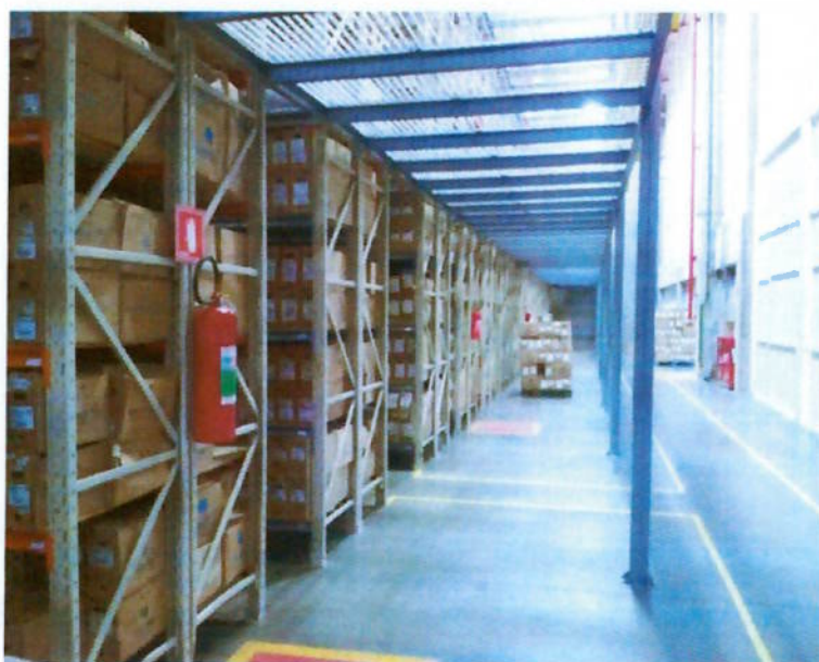
Figura 5 - Foto do térreo do Galpão na perspectiva dos corredores
